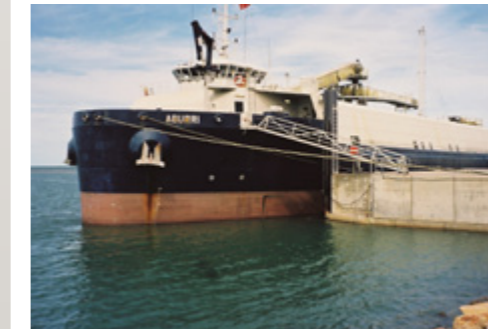
Bing Bong wharf (Australia)
