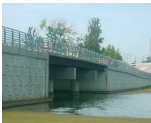
Olio Bridge (USA)
